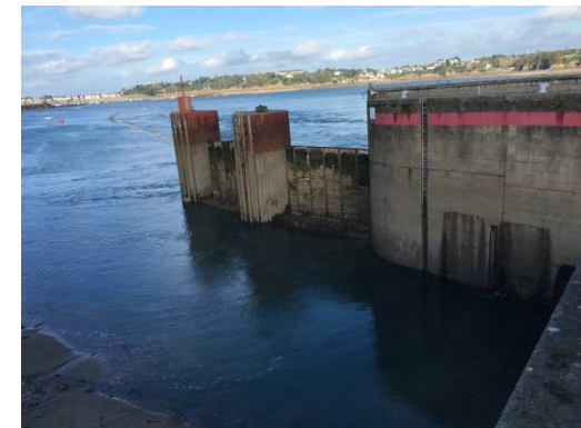
« Ducs d'Albes » ou Gabions 2 côté Mer (Travaux Hiver 2018/2019)
